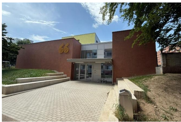
Obrázek 11 – Nový vstup do budovy školy přes přístavbu
