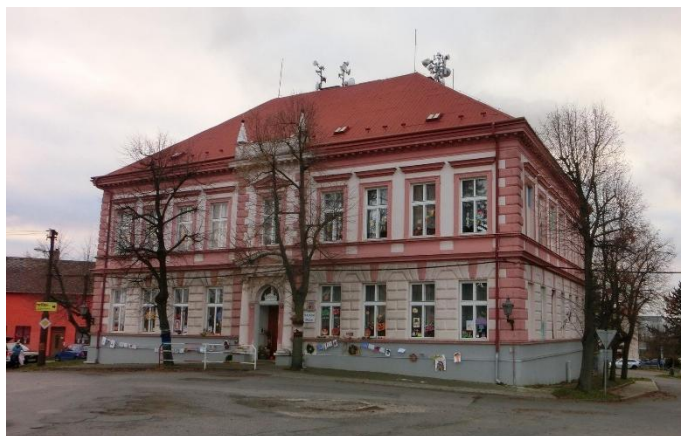
Obrázek 14 – Budova ZŠ 5. května, ve které ve školním roce 2024/25 nově probíhala výuka pobočky v Rudné
